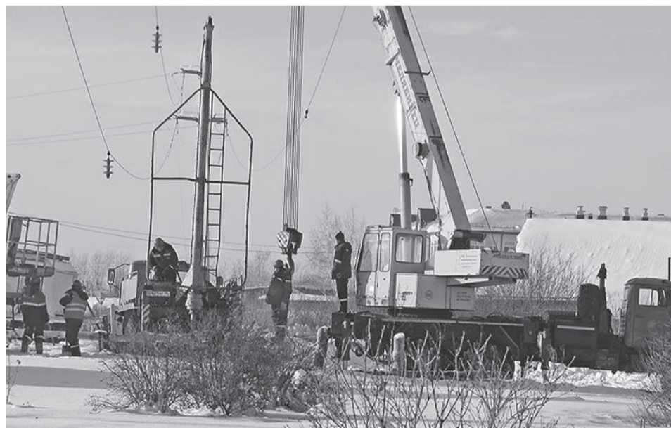
Замена повреждённой опоры на улице Павлика Морозова.
