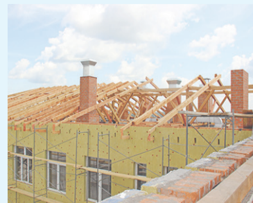
Усилия строителей сосредоточены на установке кровли.
