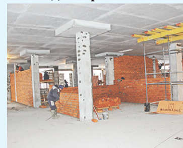
Ведётся кладка стен и перегородок на первом этаже.
