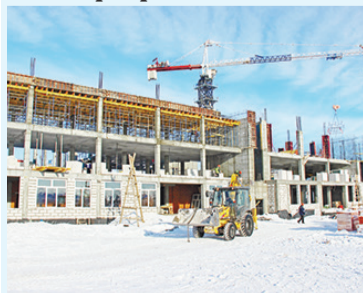
Строители вышли на четвёртый этаж.
