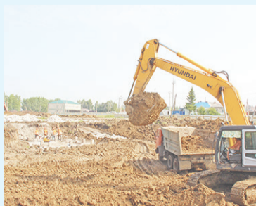
Проведена выборка грунта под котлован.
