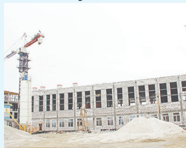
Ведётся монтаж кровли.
