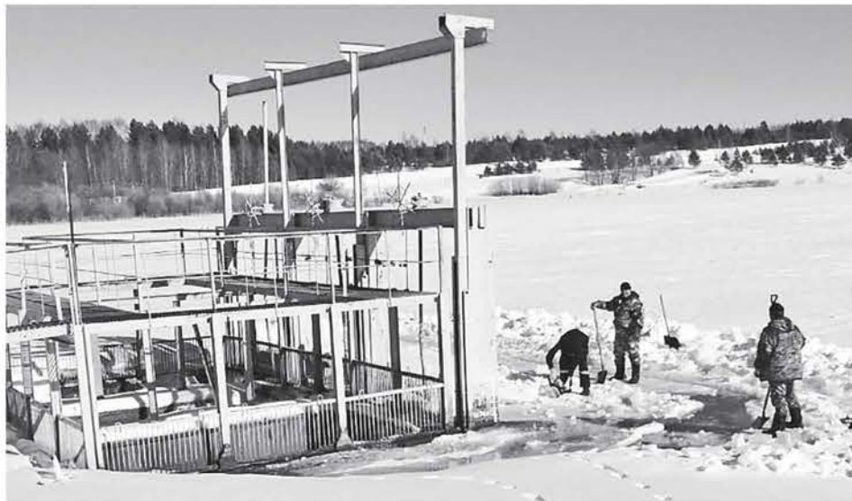
Для безопасности и быстрого прохождения льда проведено опиливание мостов и гидротехнических сооружений. Фото М. ГЛУХИХ.
