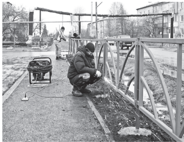
Последние штрихи дорожных строителей.
