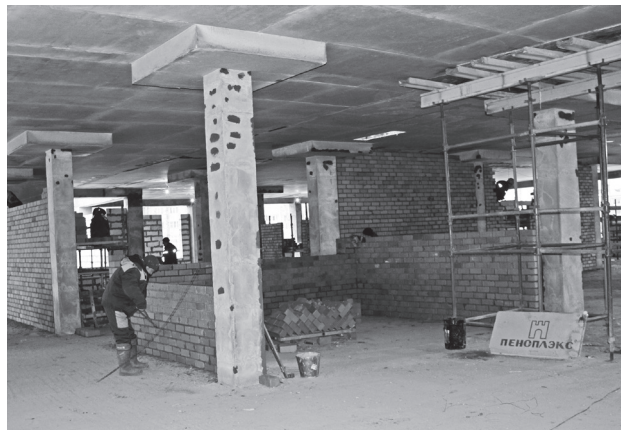
На первом этаже строители ведут кладку стен и перегородок.
