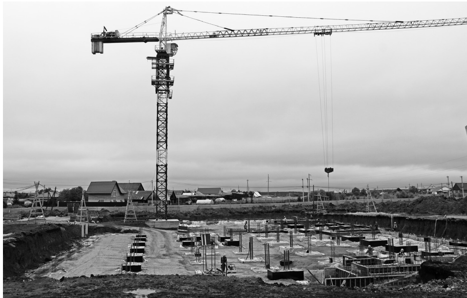
Под основным зданием полным ходом идут бетонные работы.
