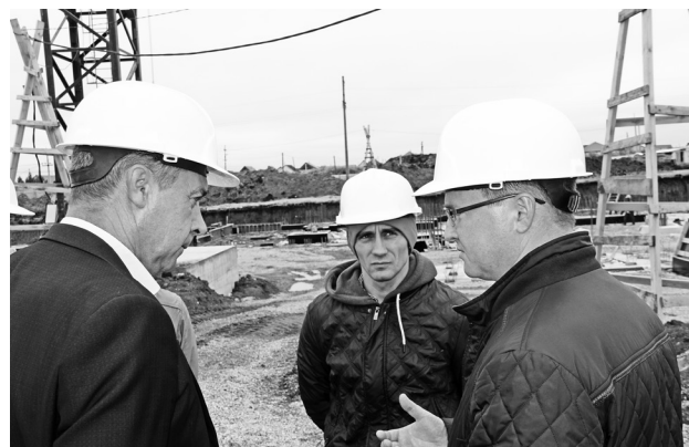
А.А. Жуков, Е.Н. Голубенко и С.В. Власов обсуждают ход строительства.
