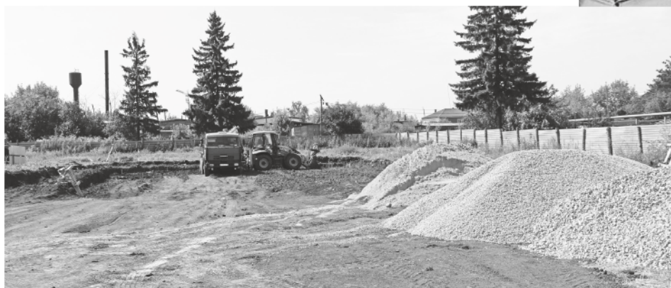
На месте будущего 24-квартирного дома ведутся земляные работы.
