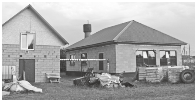
Андрей Сопегин заканчивает строительство дома.
