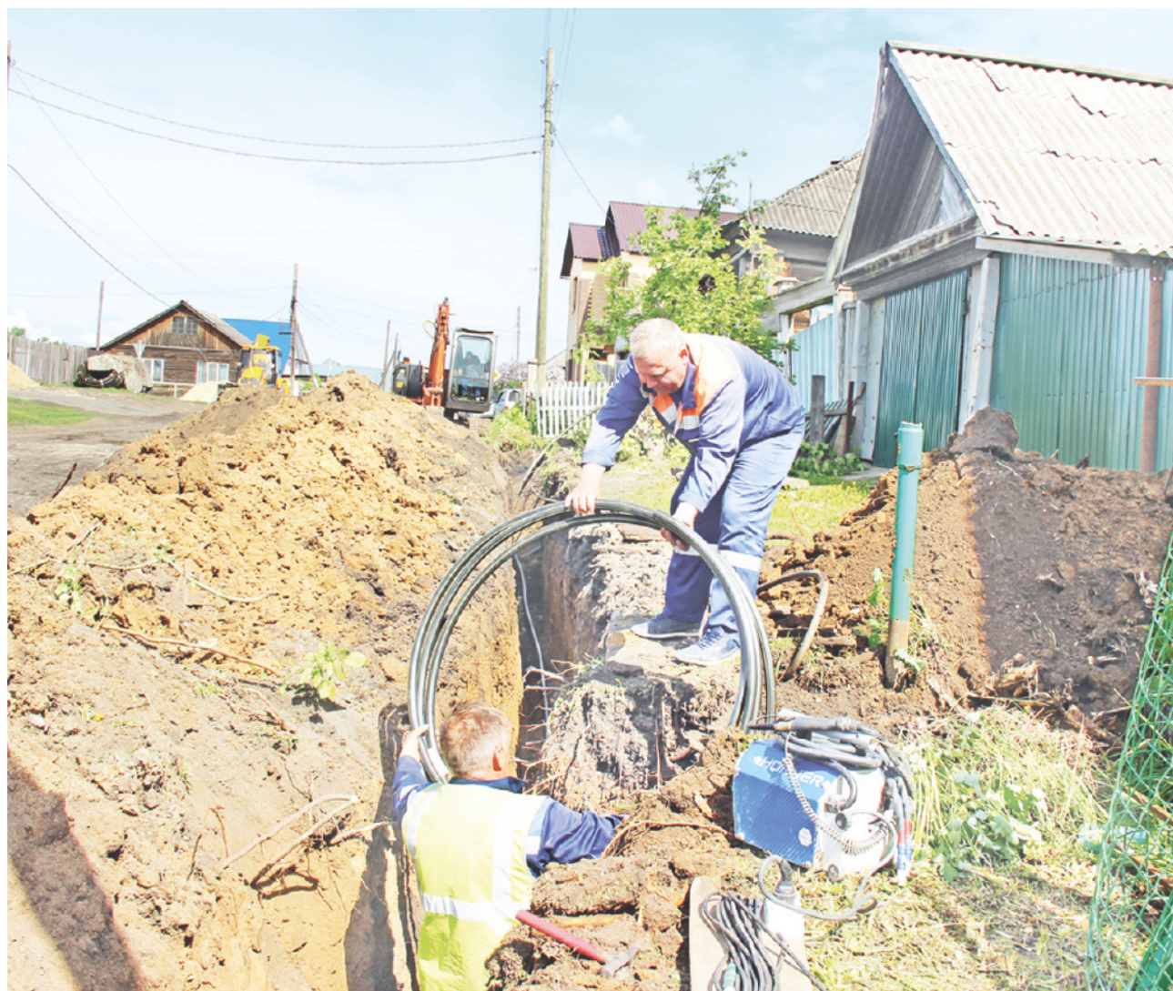
Рабочие ООО «Мехмонтаж» из Курганской области ведут прокладку газопровода по улице Крестьянской. Фото автора.
